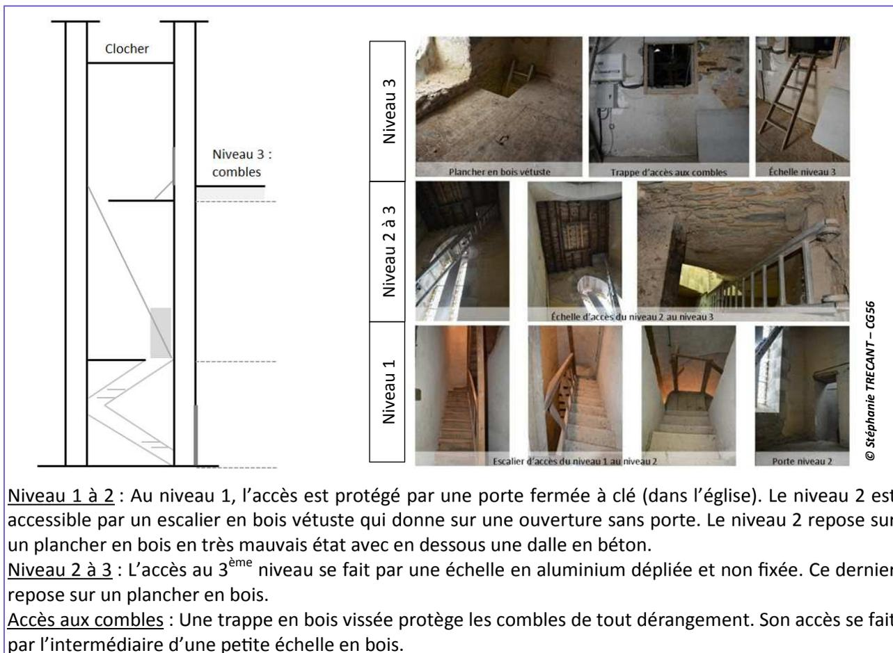
**Niveau 1 à 2** : Au niveau 1, l'accès est protégé par une porte fermée à clé (dans l'église). Le niveau 2 est accessible par un escalier en bois vétuste qui donne sur une ouverture sans porte. Le niveau 2 repose sur un plancher en bois en très mauvais état avec en dessous une dalle en béton.
